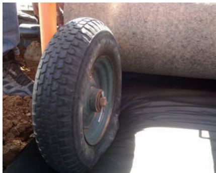
Figura 19. Roda de fixació lateral desinflada per reduir la pressió que exerceix sobre el material.
